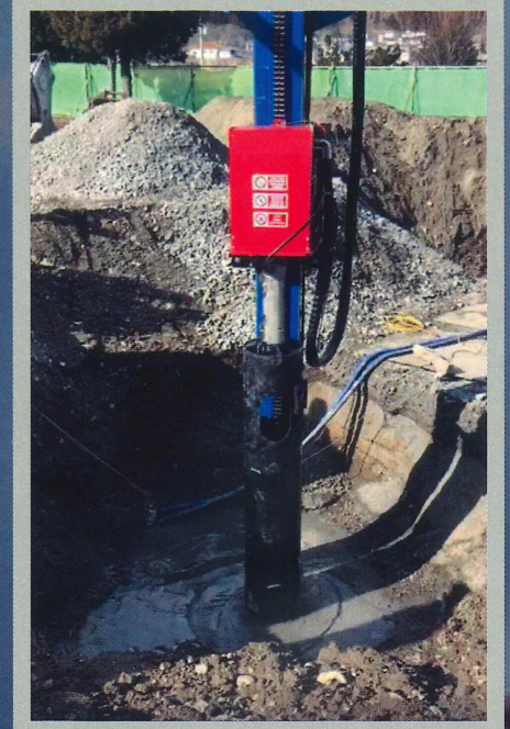
掘削終盤の作業状況
