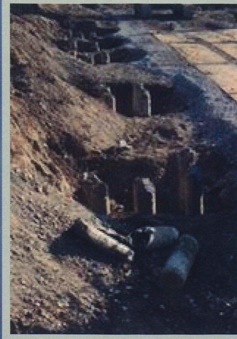
掘削初期の杭の頭出し
