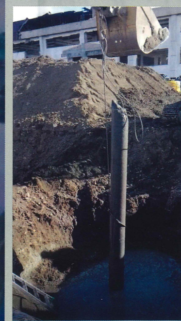
相対機にて杭引抜
