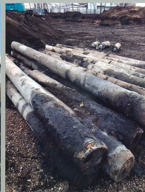
引抜後のφ350、12Mの杭
